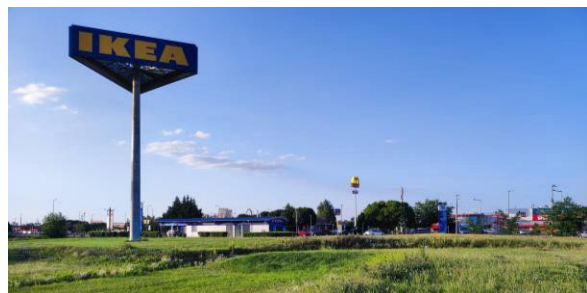
a fejlesztéssel érintett telek északi részén kialakított záportározó
