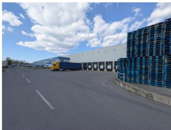
az épület főbejáratáról és a kamion dokkoló területéről készült helyszíni fotók
